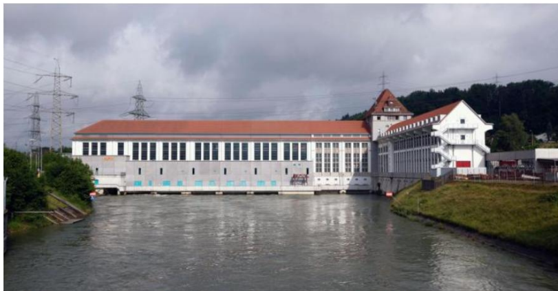
Hier in Gösgen soll grüner Wasserstoff für den Schwerverkehr produziert werden. (Foto: Alpiq)
